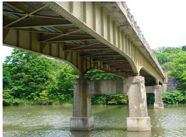
床版目地の漏水、遊離石灰
