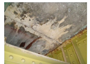
床版目地の漏水、遊離石灰
