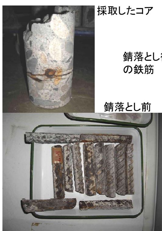
撤去橋脚の鉄筋の腐食程度
