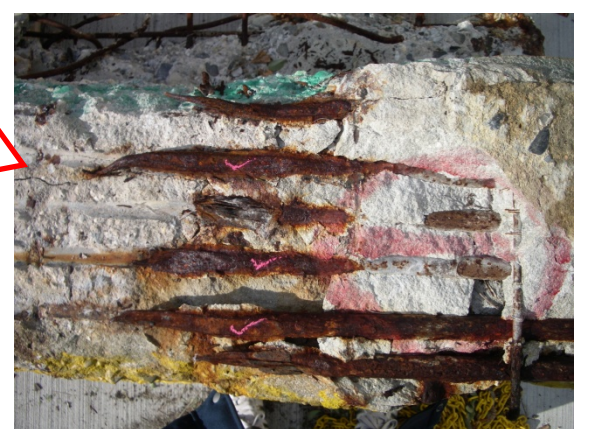
支承部の鉄筋
