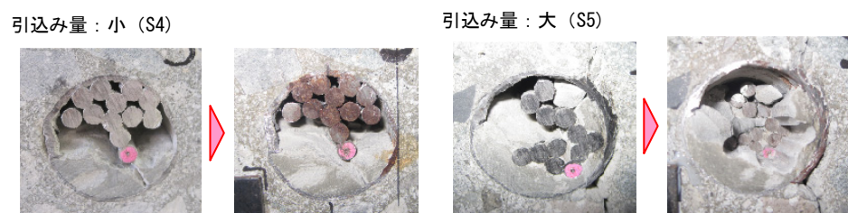
端部PC鋼材の引き込み状況(載荷試験前後)
