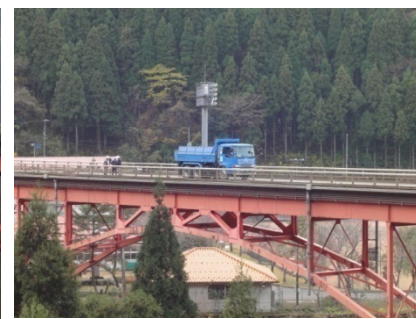
荷重車を用いた走行試験
