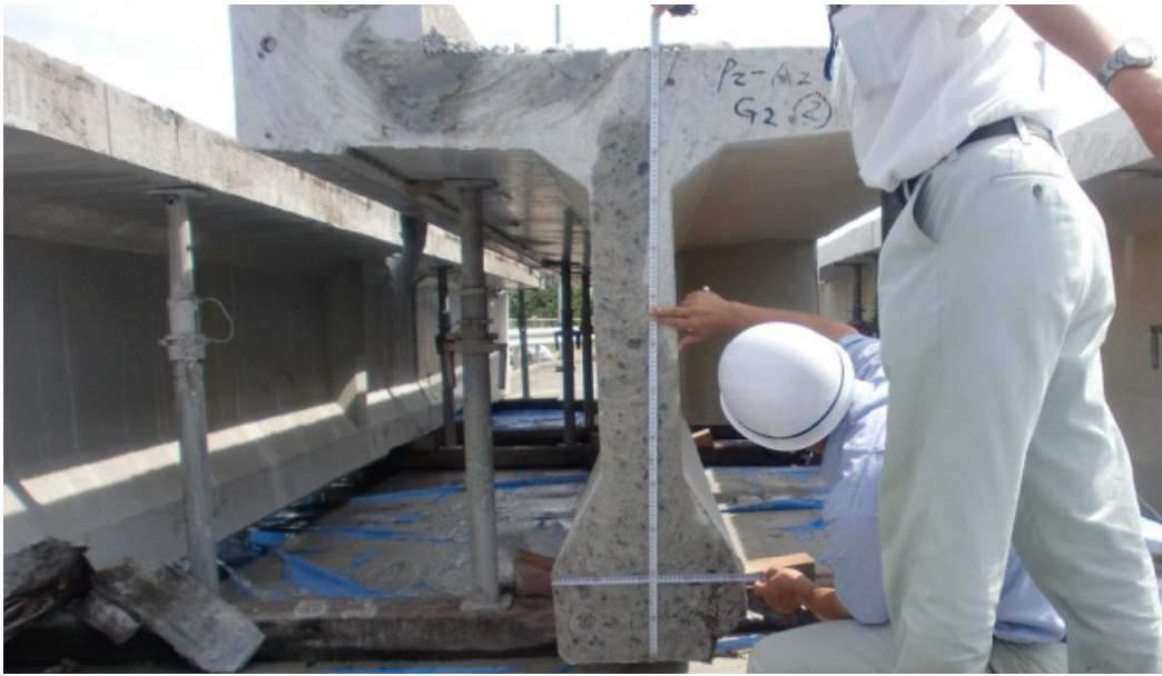
桁切断面の調査状況
