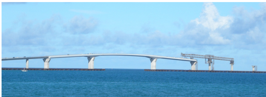
現在建設中の伊良部大橋
