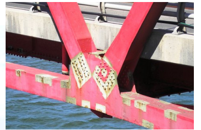
トラス格点部の腐食 47年供用, 各所に著しい腐食損傷
