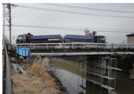
A橋荷重試験状況
