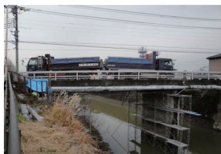
A 橋载荷試験状況
