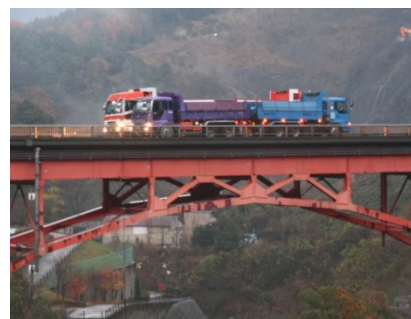
荷重車を用いた静的载荷試験
