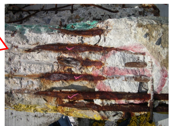
支承部の鉄筋
