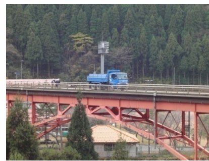
荷重車を用いた走行試験
