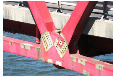
トラス格点部の腐食 47年供用, 各所に著しい腐食損傷
