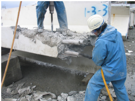
解体調査状況
