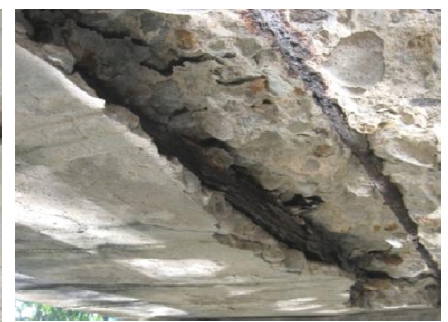
主筋の腐食
