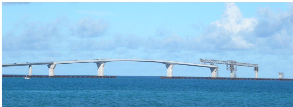
現在建設中の伊良部大橋
