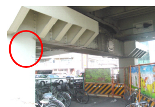
鋼製ブラケット溶接時に割れが発生 ＜鋼製橋脚の現場溶接時におけるラメラテアの発生事例＞
