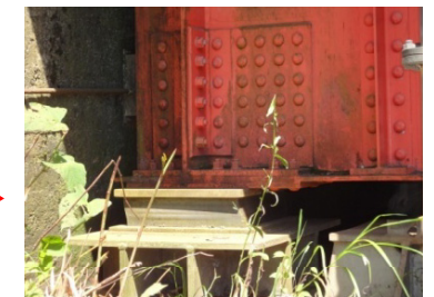
桁端部のあて板補強とゴム支承への取り替え
