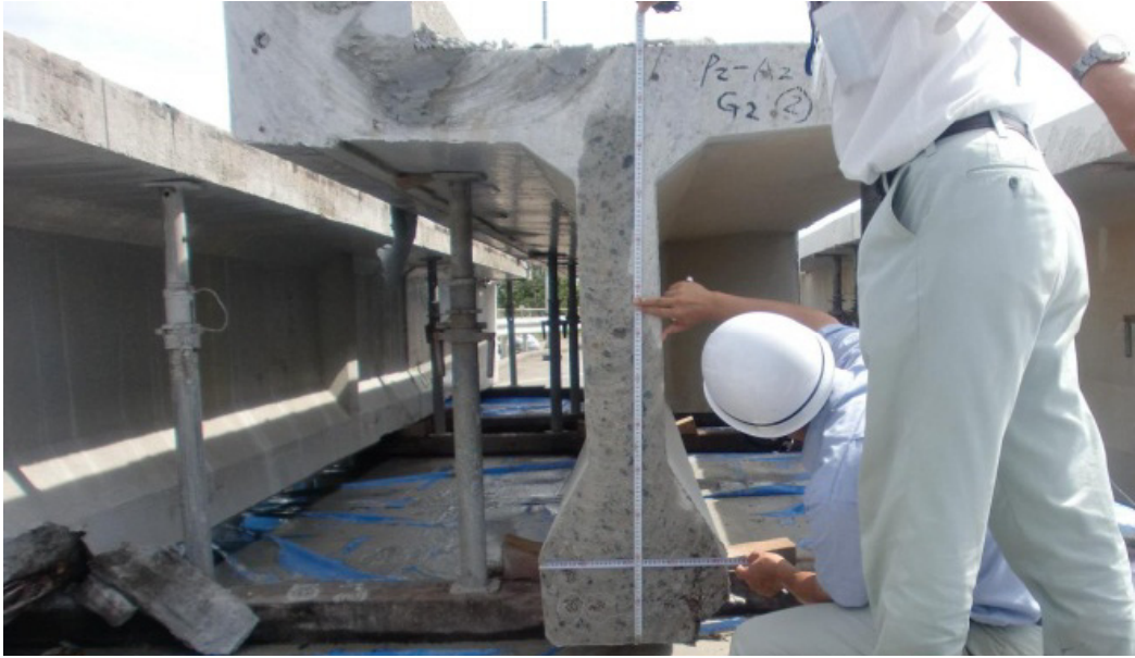
桁切断面の調査状況
