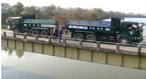
荷重車を用いた現地载荷試験
