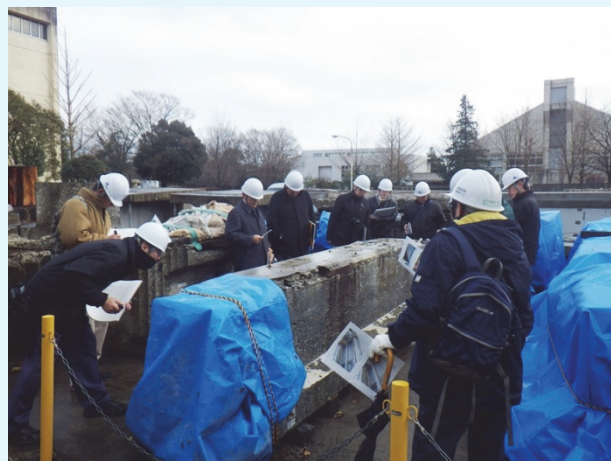
撤去部材展示施設における部材調査実習 (国土交通大学校の研修の一部として実施。 撤去された劣化部材により症例を学ぶ)
