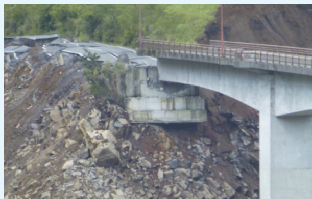
阿蘇長陽大橋の復旧：不安定地盤を除去し、将来の地盤の風化、再度の地震に対してもできるだけ致命的な被害に至らないように構造、線形等を助言
