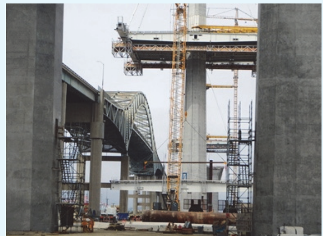
スタディツアー（斜張橋建設現場の視察）
