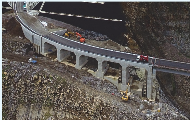
阿蘇長陽大橋の復旧：不安定地盤を除去し、将来の地盤の風化、再度の地震に対してもできるだけ致命的な被害に至らないように構造、線形等を助言
