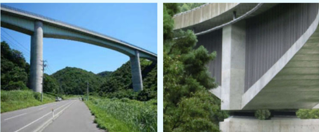
鋼・コンクリート複合構造を採用した コンクリート橋
