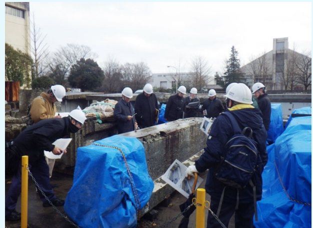
撤去部材展示施設における劣化部材の症例実習 (国土交通大学校の研修の一部として実施)
