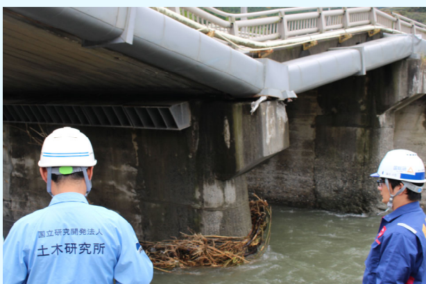
被災した道路橋の現地調査
