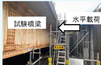
試験橋梁の載荷試験
