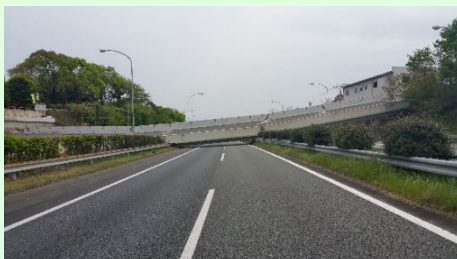
地震による落橋
