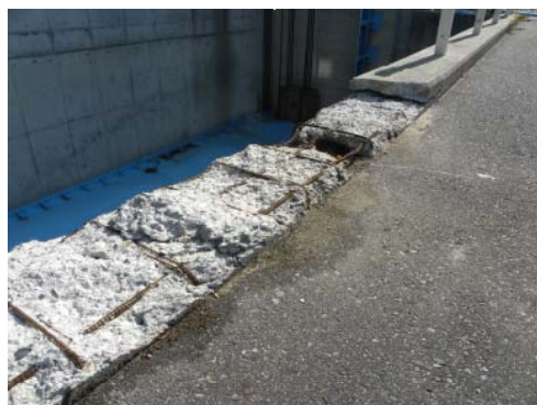
普代水門管理橋 第3径間の損傷状況
