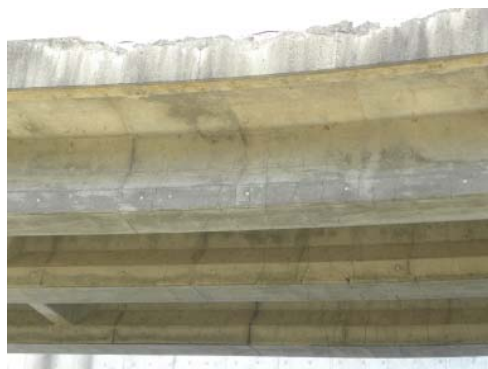
普代水門管理橋 第3径間の損傷状況
