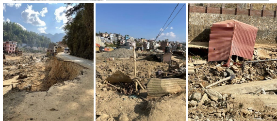
写真 3-15 カトマンズ渓谷でのインフラ及び家屋被害の様子
