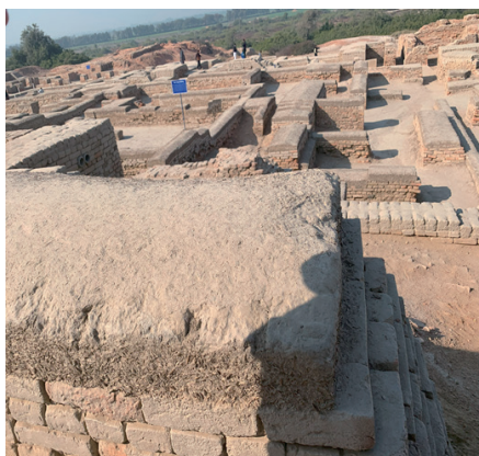
Photo 2, 3 Mud slurry and mud capping works to protect the ruins (i.e. wall and stupa dome) from extreme climatic/weather conditions in Mohenjo-Daro 写真 2, 3 極端な気候・気象条件から遺跡（壁やストゥーパのドームなど）を保護するために、スラリーや泥でキャッピングされている遺跡の様子
