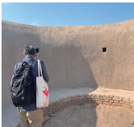
Photo 2, 3 Mud slurry and mud capping works to protect the ruins (i.e. wall and stupa dome) from extreme climatic/weather conditions in Mohenjo-Daro 写真 2, 3 極端な気候・気象条件から遺跡（壁やストゥーパのドームなど）を保護するために、スラリーや泥でキャッピングされている遺跡の様子
