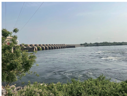
Photo 2. View of the Kpong Dam in the upstream part of the Lower Volta River 写真 2 : Volta 川下流域の上流部に位置する Kpong ダム
