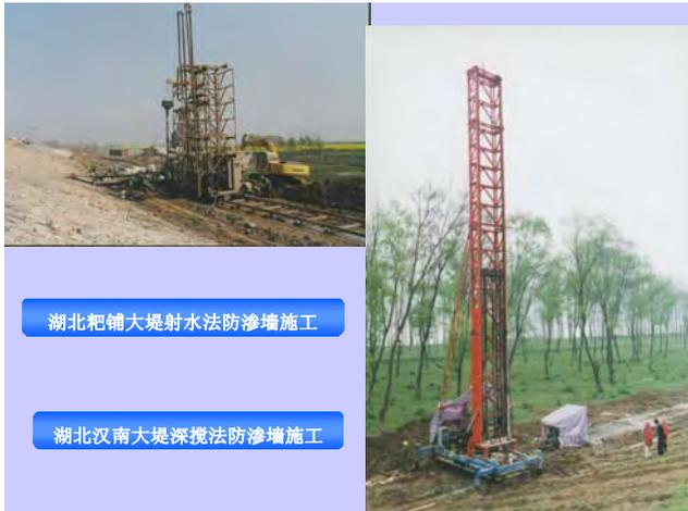
湖北耙鋪堤防における射水法の浸透防止の
