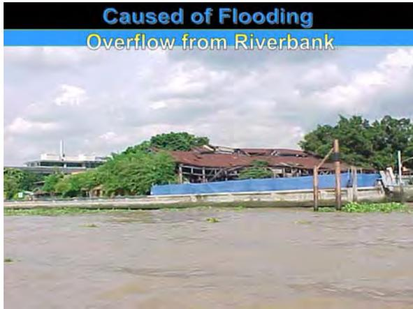
これは防護壁の例の一つです。チャオプラヤ川の水が外に溢れ出ないようにするための、水運の防護壁の一つです。
