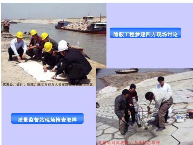
埋設工事を行う時に、四方と呼ばれる、発注者と設計者、工事管理者、施工業者の四者が集まって検討している状況です。下は品質管理の為に堤防の護岸のコアサンプル調査をしている状況です。
