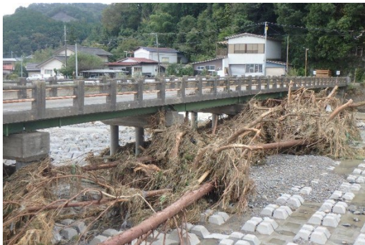
写真 3-3 常盤橋に集積した流木(栃木県佐野市)
