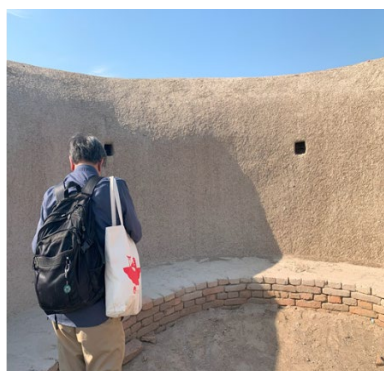
写真 3-26, 27 極端な気候・気象条件から遺跡(壁やストウーパのドームなど)を保護するために、スラリーや泥でキャッピングされている遺跡の様子
