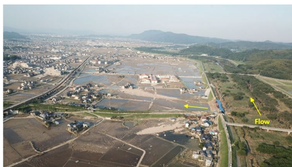
写真 3-1 小田川の破堤(倉敷市真備町、ドローンで撮影)
