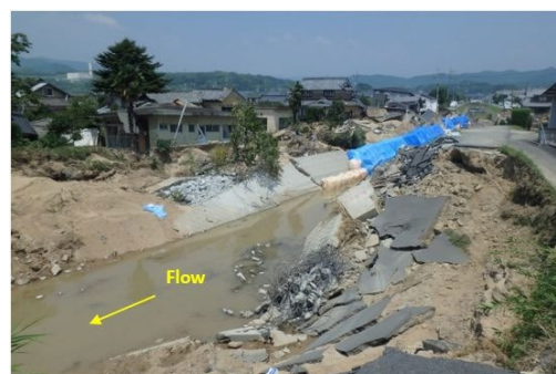
写真 3-2 末政川の破堤(倉敷市真備町)
