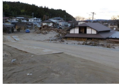
写真 4-4 土砂・洪水氾濫の状況(宮城県丸森町)
