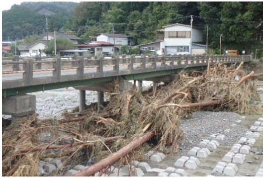
写真 3 常盤橋に集積した流木(栃木県佐野市)
