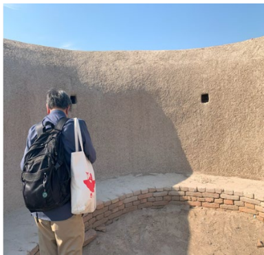
写真 17, 18 極端な気候・気象条件から遺跡(壁やストウーパのドームなど)を保護するために、スラリーや泥でキャッピングされている遺跡の様子
