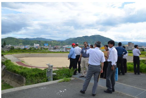
近年完成した肱川支流の調整池
