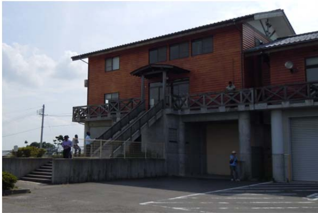
赤浜防災ステーション
