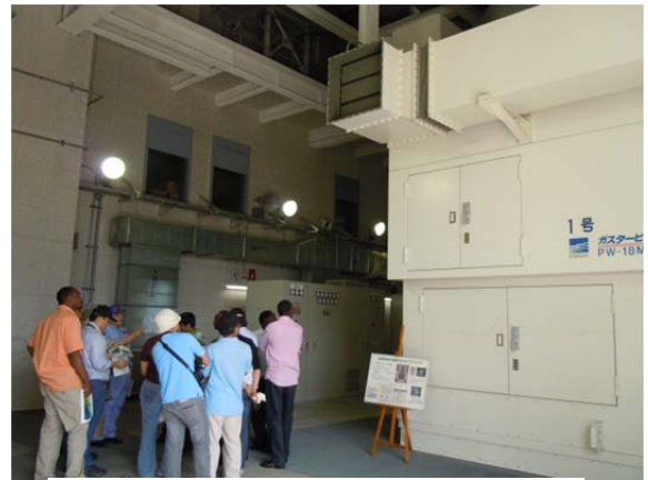
鳥屋野排水機場
