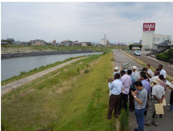
五十嵐川での堤防復旧事業
