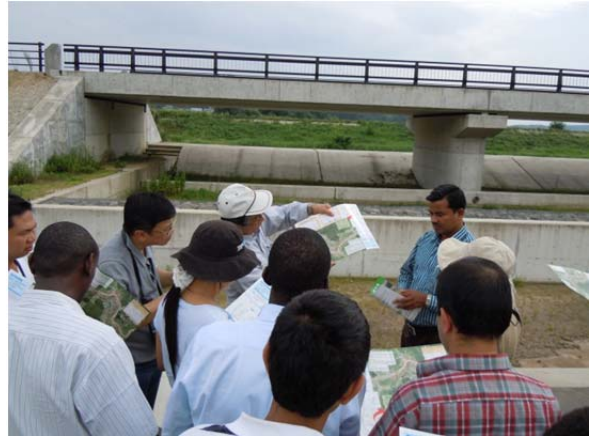
刈谷田遊水地（E池）の越流堤
