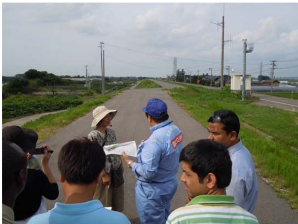
保明新田付近の腹付築堤
