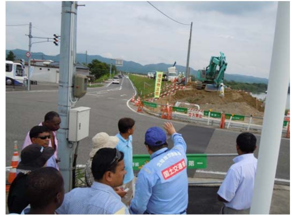
小須戸橋での築堤
