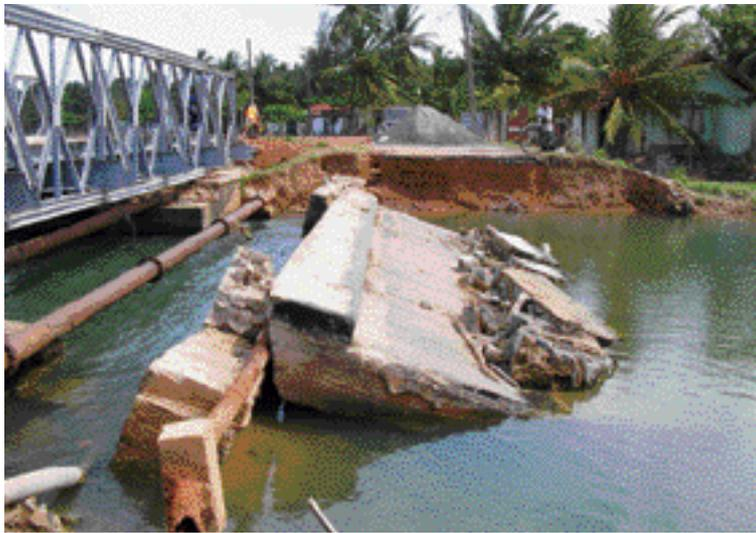
写真 - 2.3.2.8 津波により橋台裏が洗掘されて落下した橋と仮設橋（スリランカ）
