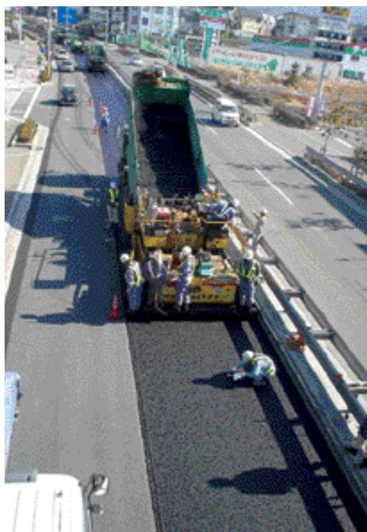
写真 - 2 再生排水性舗装の試験施工状況
