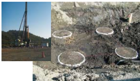
写真-1.5.28 ALiCC工法の施工状況
