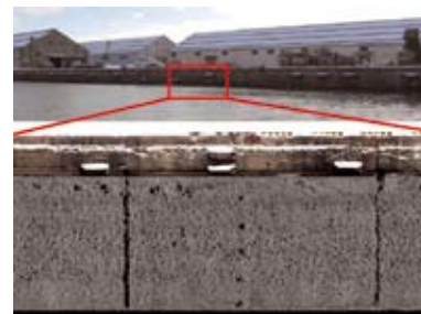
図5.8 音響カメラを用いて撮影したデータによるモザイク図 (陸上部+水中部)
