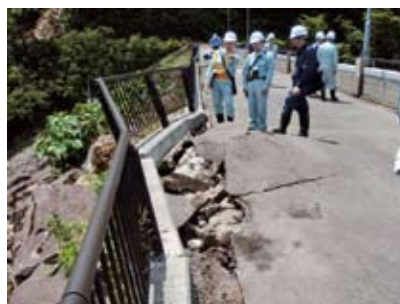
ダムの安全性確認(石淵ダム)
