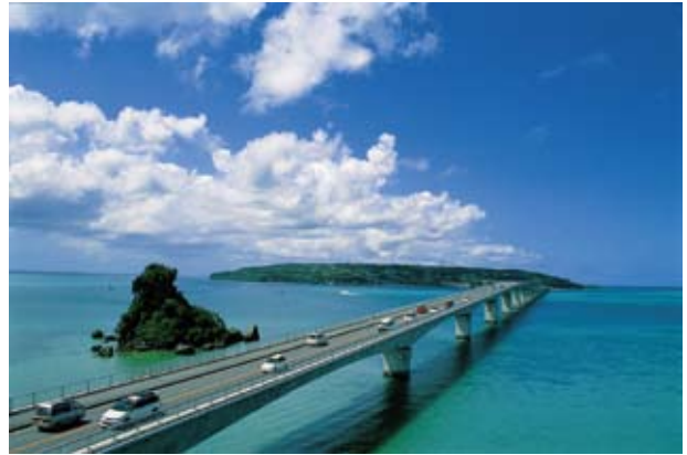
100年耐久性検証プロジェクトの 沖縄県離島架橋例（古宇利大橋）
