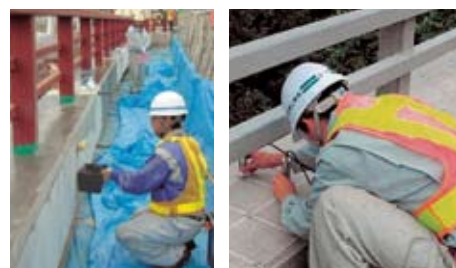
写真11.2 コンクリートの耐久性向上のための表面含浸材の塗布、計測状況
