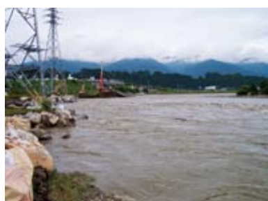
【天竜川堤防決壊状況】
