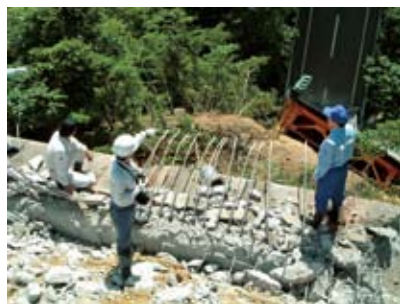
落橋した祭時大橋の調査
