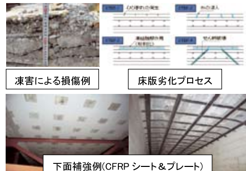
図11.3 凍害等の影響を受けるRC床版の補修補強
