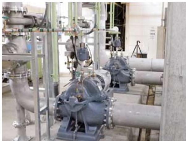
写真－7.1.5 ダム水理実験施設改修（22年度）
