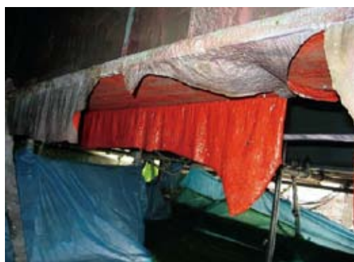
ものづくり日本大賞を受賞した環境対応型塗膜除去技術（インパイロワン工法）
