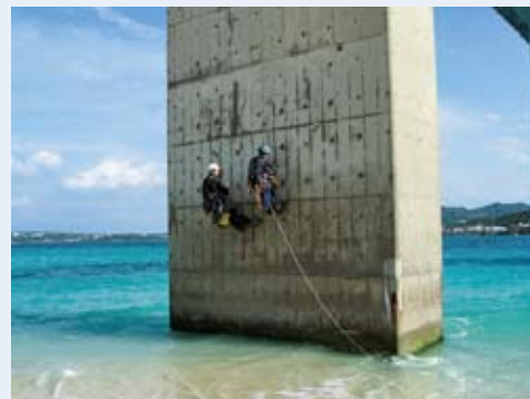
写真－2 瀬底大橋における塩害調査
