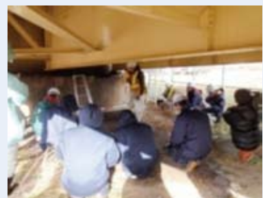
現地点検実習の状況
