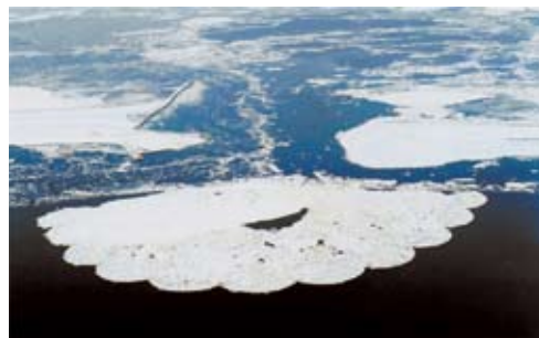
写真5.1 サロマ湖口流水制御施設
