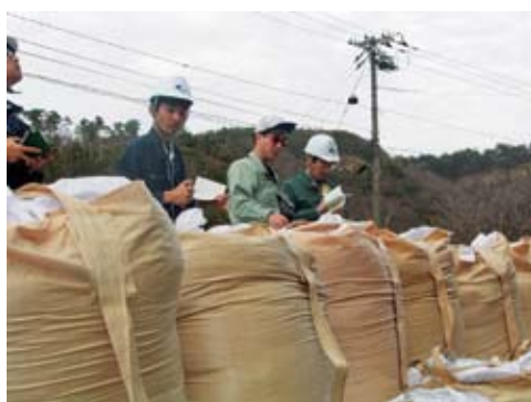
斜面崩壊への応急対策(土のうの設置) とその効果の確認の様子
