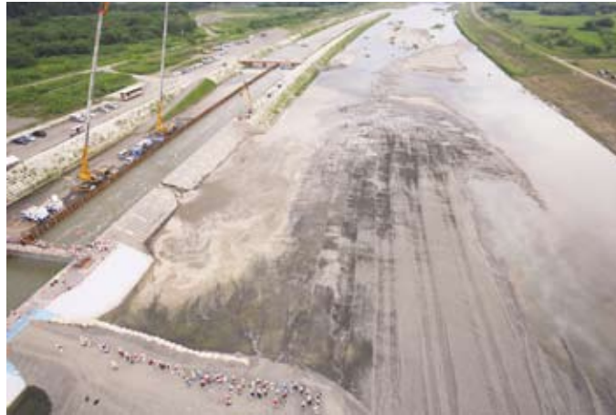
写真－1.5.24 越水破堤実験の様子
