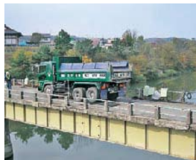
写真－1.5.21 大型トラックでの載荷
