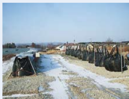
(b)冬期の土のうの状態
