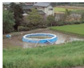
図2.4 基礎地盤漏水
