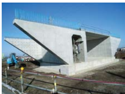
写真-1.5.29 複合構造横管渠工の施工状況
