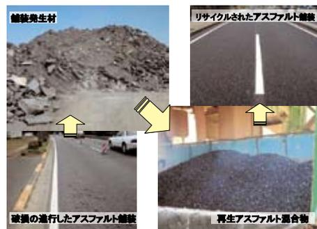
図12.2 劣化アスファルト舗装の再生のフロー
