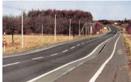
写真11.1 長期にわたり沈下が発生し、路面が波打つ泥炭地盤上の道路
