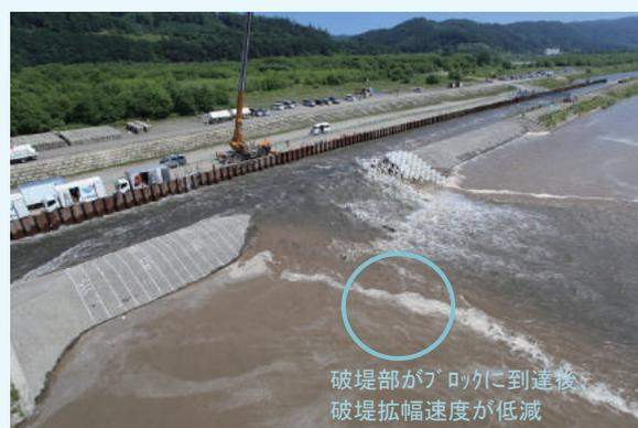
写真-2 ブロックにより破堤拡幅が抑制
