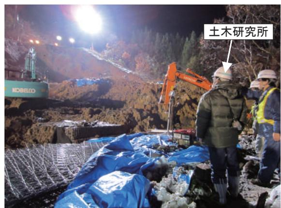
写真-1.3.6 不安定土砂の掘削方法の指導
