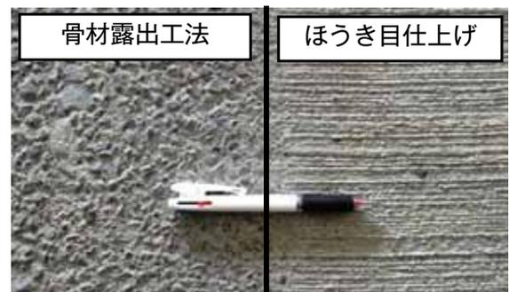
骨材露出工法とほうき目仕上げ
