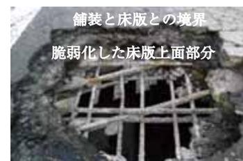
RC 床版の上面脆弱化後の陥没例
