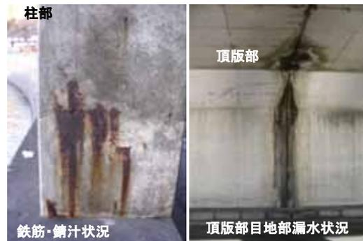
既設落石覆工の損傷事例
