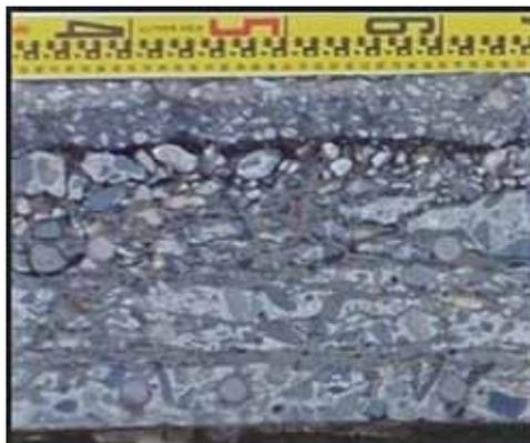
床版切断面の損傷劣化
