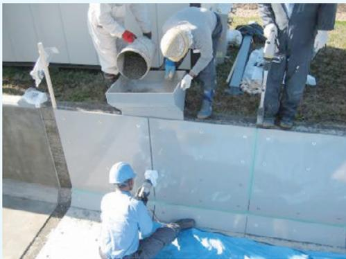
写真-1 側壁打設状況
