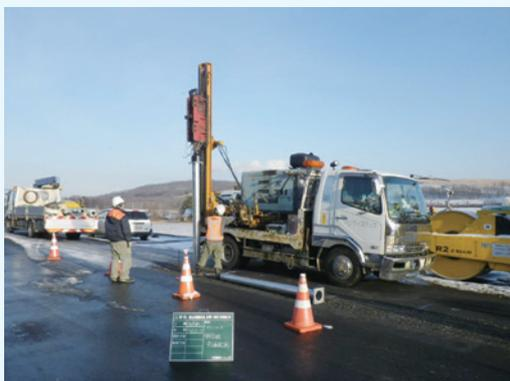
写真-2 端末基礎杭の打ち込み
