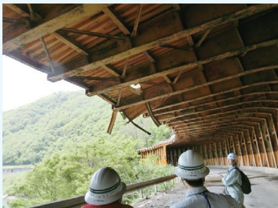
写真-3 スノーシェッドの被災状況確認
