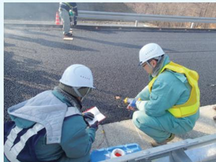
写真-2 北海道型 SMA の温度測定状況
