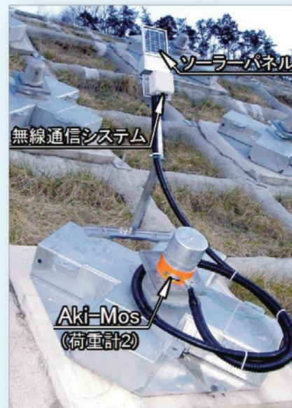
写真-1 システム設置状況
