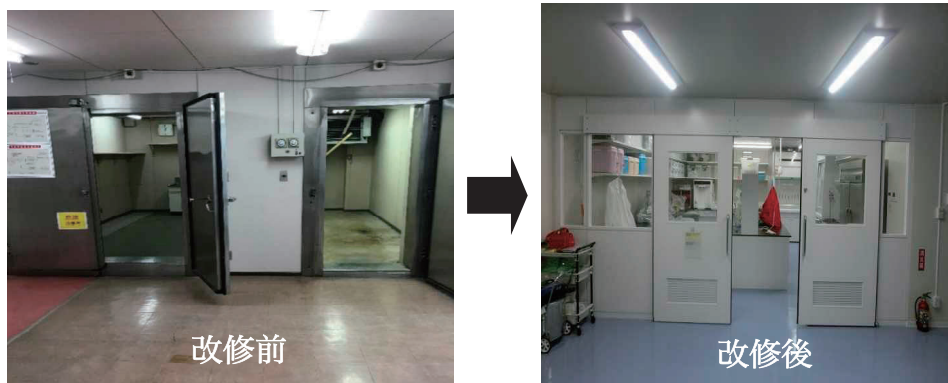
水質分析施設改修（寒地）[R3]
