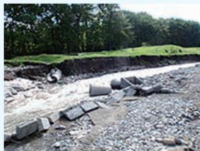
写真-1 水路護岸の損壊と法面の侵食状況
