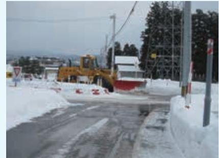
写真-1 除雪ドーザによる作業
