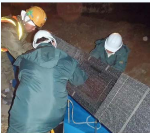
写真-2 人力による設置状況
