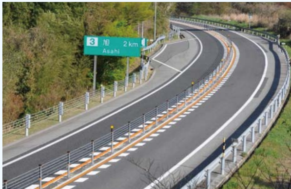
写真-1 高速道路暫定2車線区間設置状況
