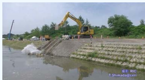
写真-2 締切作業実験（資材投入）
