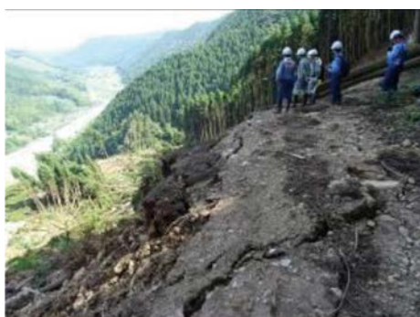
写真-1.1.3.1 地すべり崩壊の全景
