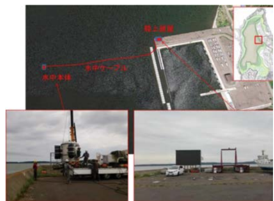
図-5 試験プラントの建設
