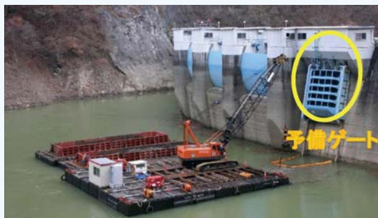
写真-3 ダム上流での浚渫作業の状況 (平成29年11月29日)
