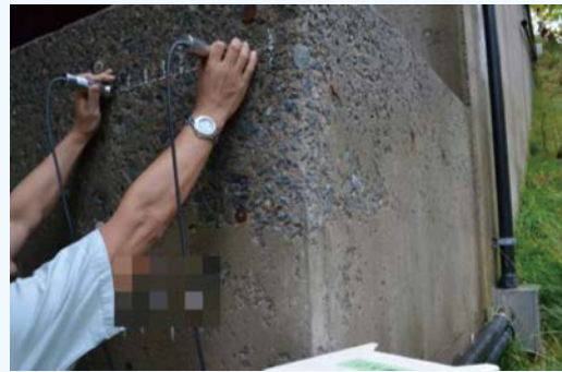
写真-1 表面走査法による調査状況
