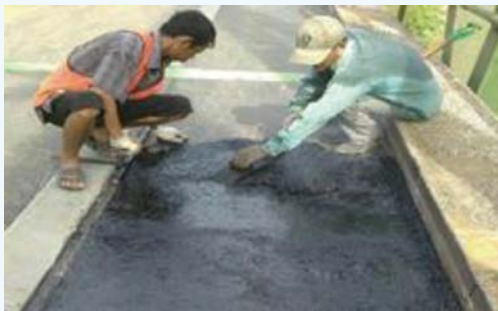
写真-1 現地での舗装の試験施工の状況
