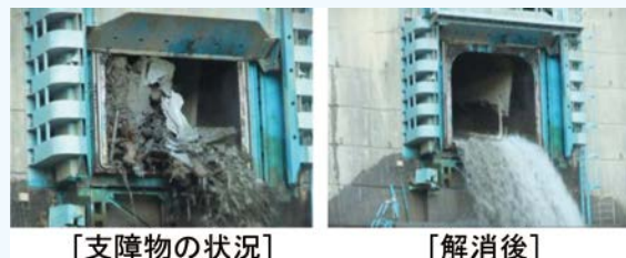
写真-4 不具合が解消されたゲート (平成29年12月09日)
