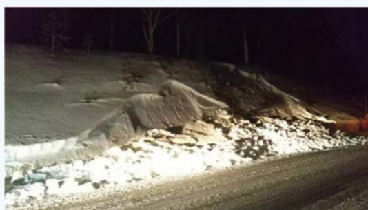
写真-3 雪崩発生状況 (釧路開建提供)
