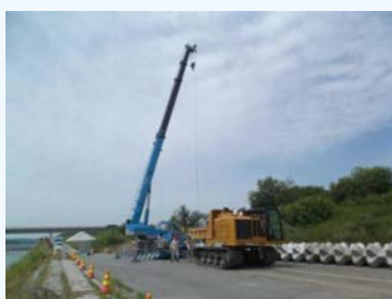
写真-1 締切作業実験（資材積込・運搬）
