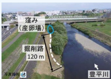
写真-3 寄州上流部に造成した掘削路
