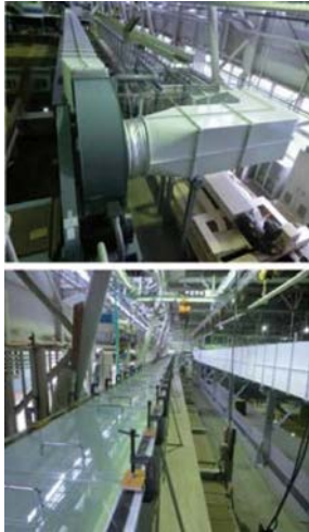
風洞装置付二次元波造水路改修
