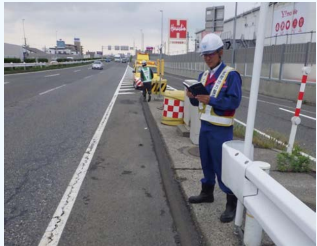
写真-2 現場での舗装点検必携の活用
