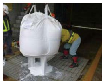
散布水溶液作製状況 (NEXCO 中日本)
