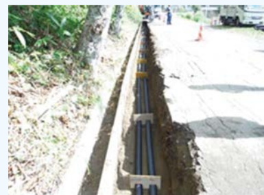
写真-1 浅層埋設の施工状況 （資料提供：千歳市）
