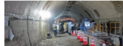
図-6 インバート追加設置の試験施工
