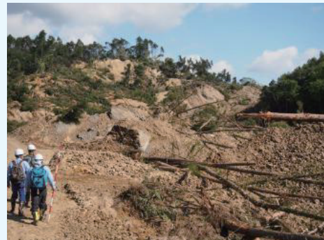
写真-2 地すべり土塊踏査の様子
