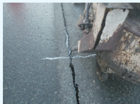
写真-4 クラックシール材施工状況
