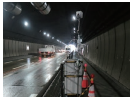
写真 換気実態調査の状況
