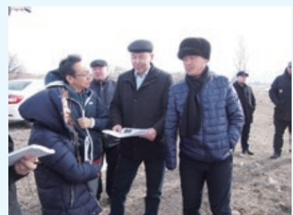
写真-2 「道の駅」建設予定地での道路局長や NGO への技術指導
