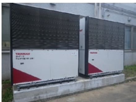
土木研究所研究本館空調設備更新
