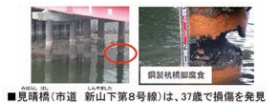
図-2 重大な損傷事例
