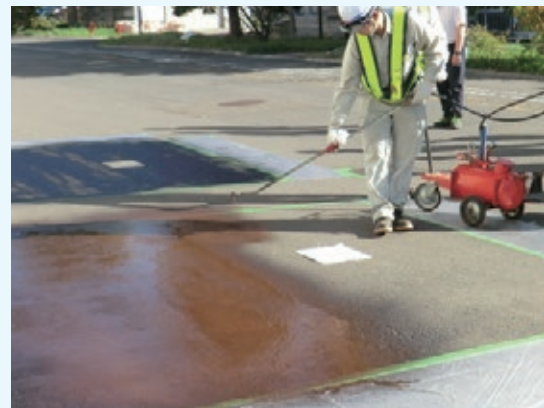
写真-2 フォグシールの塗布量確認試験
