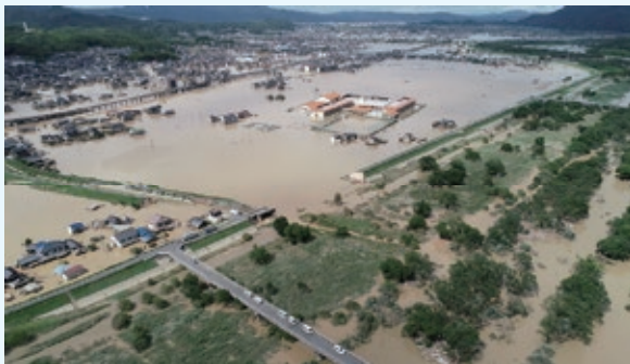
写真-1 小田川で発生した堤防決壊 〔写真提供：国土交通省 中国地方整備局〕
