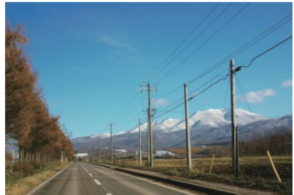
図-1 世界自然遺産の地域において背景の山並みを阻害している電線電柱
