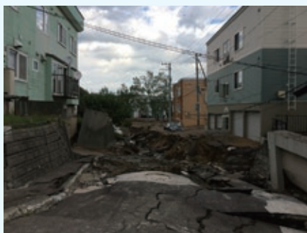
写真-3 里塚における液状化被害
