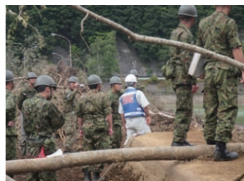
写真-1.1.3.6 厚真ダム復旧に向けた技術指導
