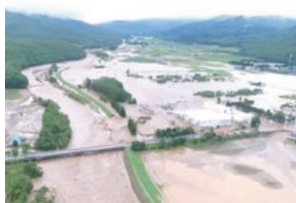
図-1 石狩川水系空知川の破堤状況 (平成28年8月)
