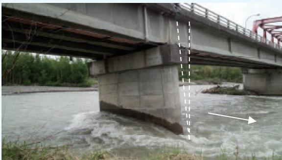
写真-1 橋脚の沈下・傾斜（清水町共栄橋）
