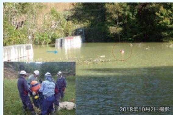
写真-4 天然ダムの決壊の危険性を監視する土研式投下型水位観測ブイ
