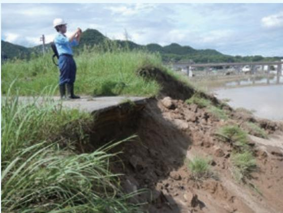
写真-3 小田川堤防決壊箇所の確認
