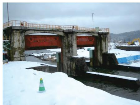
図-3 凍害と摩耗を受ける頭首工の堰柱と摩耗と腐食を受けるゲート
