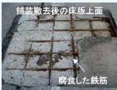
写真-1 橋梁の鉄筋コンクリート床版の塩害劣化事例（平成26年1月22日「高速道路資産の長期保全及び更新のあり方に関する技術検討委員会」報告書より）
