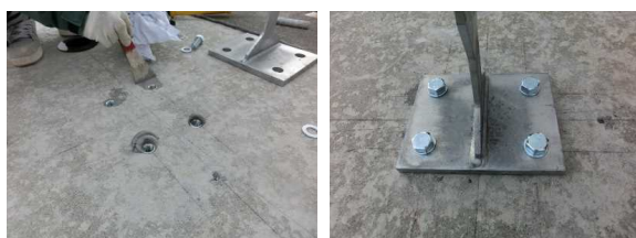
写真-1 あと施工アンカー施工状況 （左上：穿孔、右上：金属系施工状況、 左下：接着系施工状況、右下：支柱固定状況）
