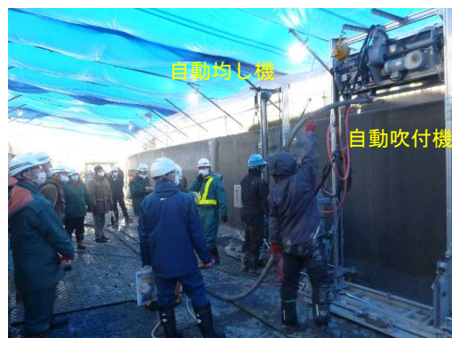
写真-2 機械化施工実証試験の現地見学会の様子
