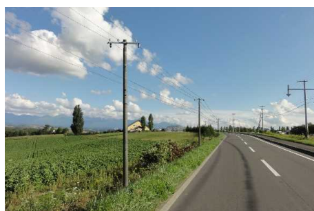
写真-1 地中化ニーズの高い郊外部の道路
