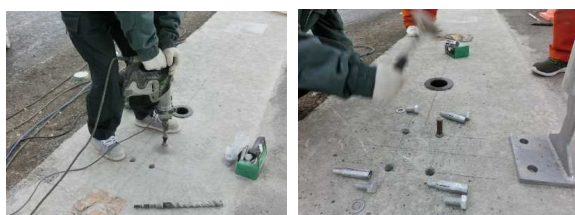
写真-2 金属拡底式あと施工アンカーによる 端末金具の設置
