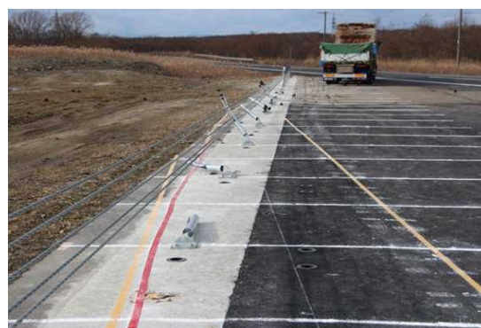
写真-3 コンクリート舗装での大型車衝突試験
