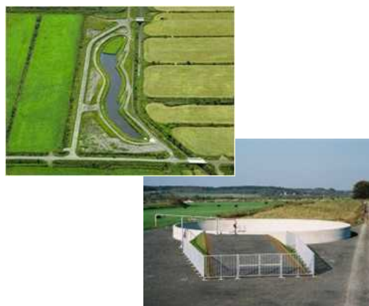
図-4 酪農地域の水質対策事例（遊水池）とふん尿処理施設
