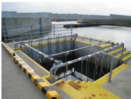
写真-2 漁港蓄養施設でのアサリ垂下養殖試験
