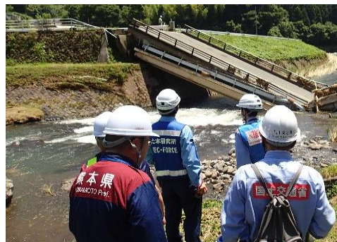
写真-1.2.1.8 落橋現場での技術指導状況
