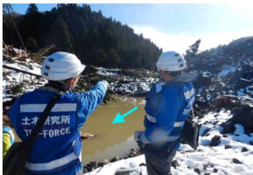
写真-1.2.1.1 河道閉塞部の土砂堆積状況の調査状況
