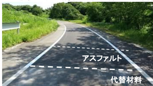
図-2 舗装走行実験場での耐久性評価
