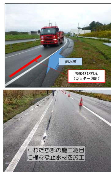
図-1 走行実験場での試験（上）と一般国道での試験施工（下）
