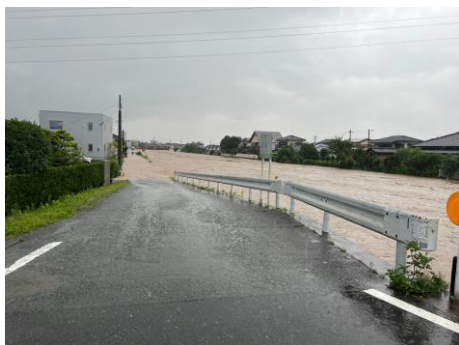
写真-1.2.1.13 巨瀬川の浸水の被害状況
