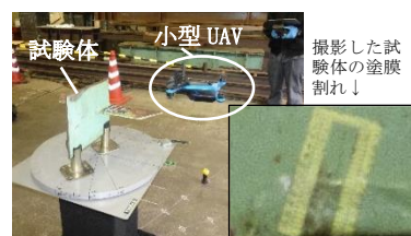
図-1 小型 UAV による塗膜割れの撮影状況
