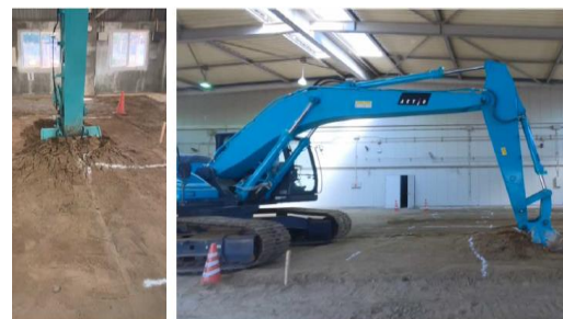
写真-1 MC対応油圧ショベルによる掘削実験
