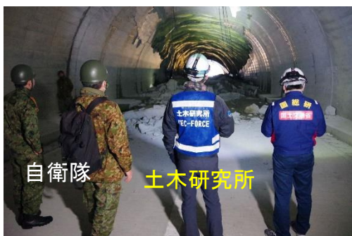
写真-3 現地調査・技術支援の状況（北陸地方整備局提供）
