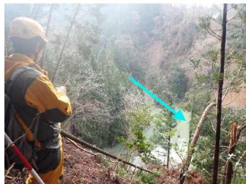
写真-1 河道閉塞の危険性評価のための現地調査
