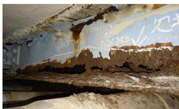
写真-1 鋼橋の腐食の例
