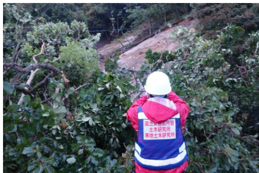
写真-1.2.1.11 国道336号の現地状況
