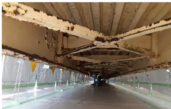
写真-3 側道橋の部材更新状況（左：施工前、右：施工後）
