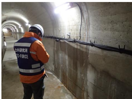
写真-1.2.1.5 小屋ダムの監査廊における亀裂の調査状況
