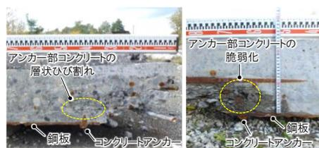
積雪寒冷地特有の補強済床版の損傷形態
