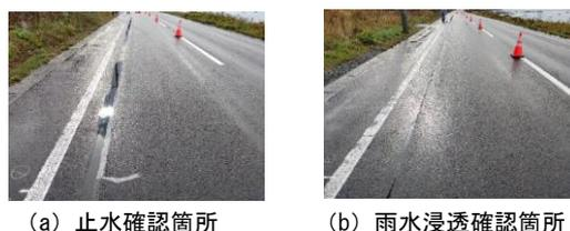
写真-2 止水対策施工箇所の止水状況(供用2ヶ月)
