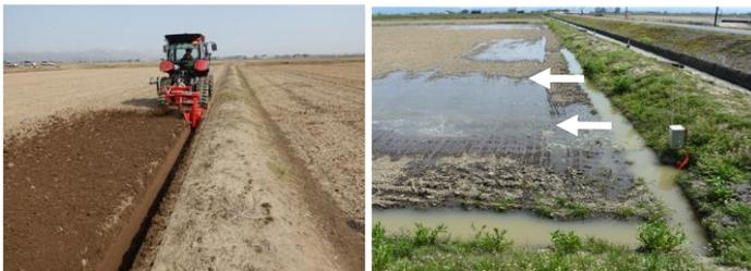
図-1 圃場内明渠の掘削 図-2 圃場内明渠からの横越流
