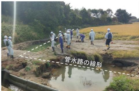
図-1 地震時における管水路曲管部の被害状況
