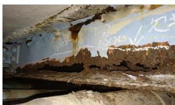
写真-1 鋼橋の腐食の例
