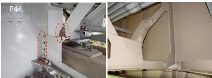
図-1 地震による鋼橋(対傾構)の損傷事例
