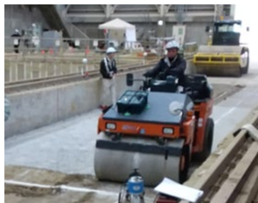
写真-2 加速度応答システム実験状況
