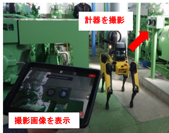
写真-1 四足歩行ロボットの点検巡回模擬試験
