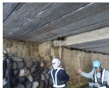
写真-1 非破壊技術を活用した実橋調査
