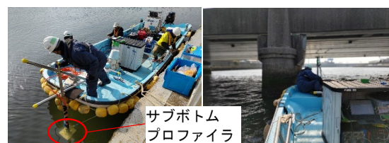
実橋での調査の様子
