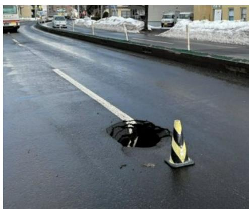
写真-1.2.1.7 空洞発生初期の陥没状況
