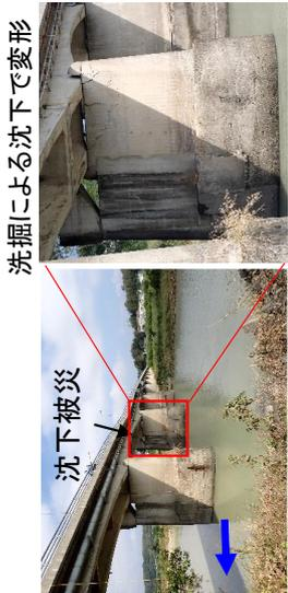
二極化した河道における橋梁沈下被災事例
