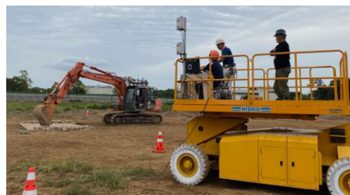
直接目視による遠隔操作状況（土研構内）
