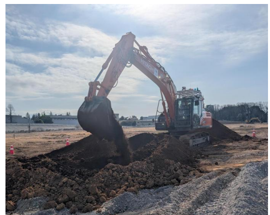
写真-1 掘削時データ取得実験状況
