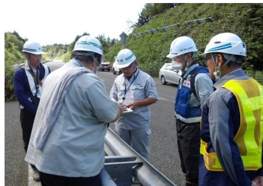
写真-1.2.1.4 現地における応急対策の技術指導状況
