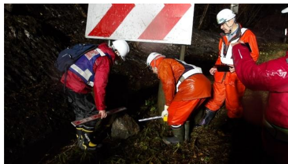
写真-1.2.1.6 落石防護施設周辺の確認状況
