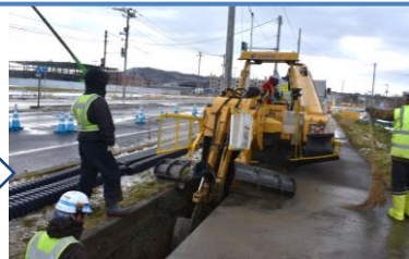
▲掘削が高速であり、工程の多くを占める土工時間を短縮
