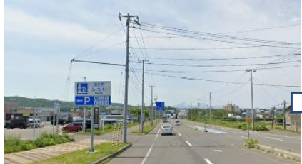
▲地域防災拠点「道の駅るもい」では早急な無電柱化が必要 →トレンチャー工法を検討
