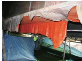
鋼橋塗装のLCC縮減のためには、一般塗装系塗膜を重防食塗装系に替える必要があります。このため一般塗装系塗膜を除去しジंकリッチペイントを塗付することが欠かせません。本講演では、有害物質(鉛・クロム)を含む一般塗装系塗膜を容易かつ確実に除去・回収できる環境安全性に優れた塗膜除去工法「インバイロワン工法」について施工事例を交えて紹介します。
