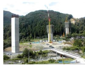
山岳部の橋梁で背の高い橋脚を建設する場合、従来の鉄筋コンクリート構造の橋脚では、鉄筋量が多く、配筋作業が煩雑であることから、工費が高い、工期が長いという問題がありました。そこで、軸方向鉄筋および中間帯鉄筋に代わる部材として考案したスパイラルカラム(H形鋼材や鋼管の周囲に螺旋状のPC鋼棒を配した部材)を用い、優れた耐震性、施工性、経済性を有する高橋脚建設新技術・3H工法を開発しました。本講演では設計手法やコスト縮減効果について施工事例を交えて紹介します。
