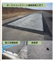
道路交通騒音の軽減策としてアス ファルトを用いた排水性舗装が広 く普及していますが、積雪寒冷地 のような過酷な環境下では、除雪 車による摩耗やタイヤチェーンに よる損傷により早期の機能低下が 問題となっており、高強度、高耐 久、高機能を有する排水性舗装技 術が求められています。
