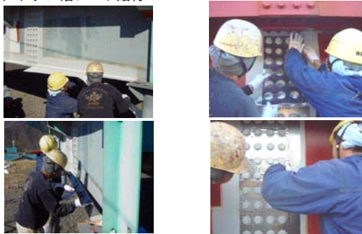
チタン箔シート貼り付け作業状況
