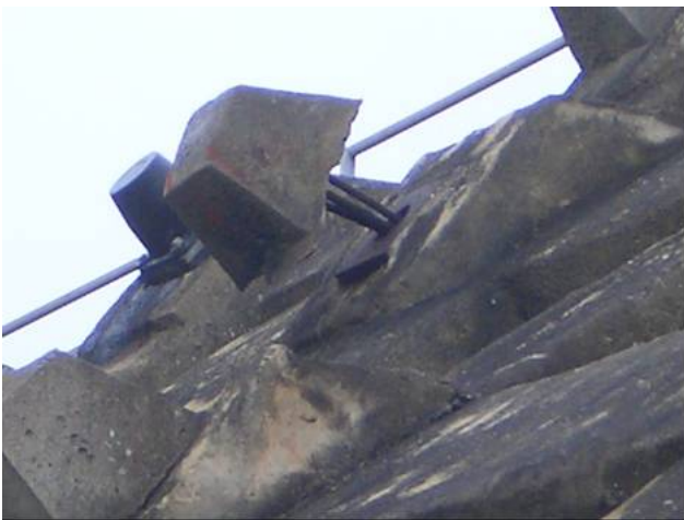
鋼より線タイプ より線の浮き上がり
