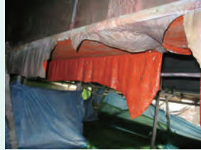
塗膜の除去状況
