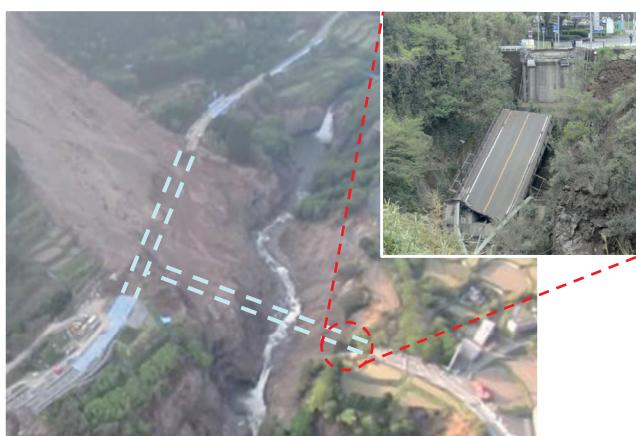
写真-9 地盤変状の影響による落橋
