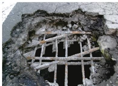
写真－1 凍害等による床版の抜落ち
