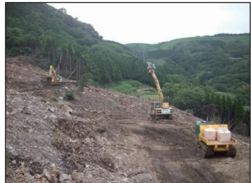
写真-13 阿蘇大橋地区における斜面の無人化施工
