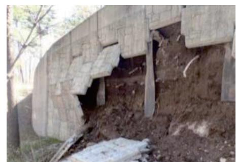
写真-2 壁面材の脱落（補強材破断）
