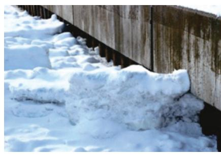
写真－5 海氷の接触等による鋼矢板の損傷
