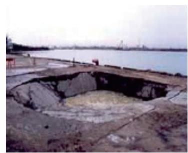
写真－6 岸壁エプロンの陥没
