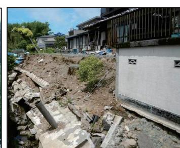
写真-6 人工斜面の崩壊
