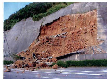
図-4 老朽化した道路のり面施設の崩壊
