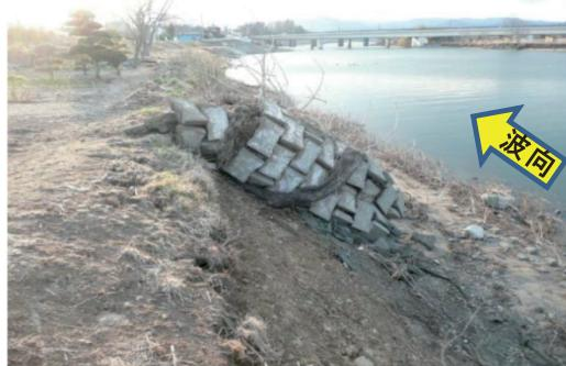
写真-1 河川津波による堤防の被害状況
