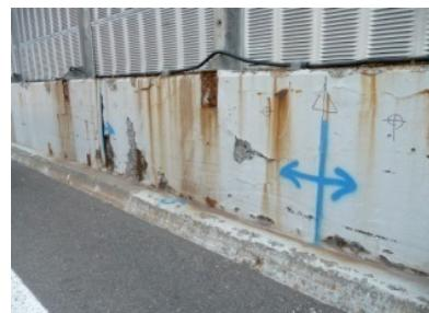
写真－2 凍害等による壁高欄の劣化
