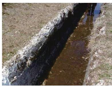
写真－4 凍害による開水路の劣化
