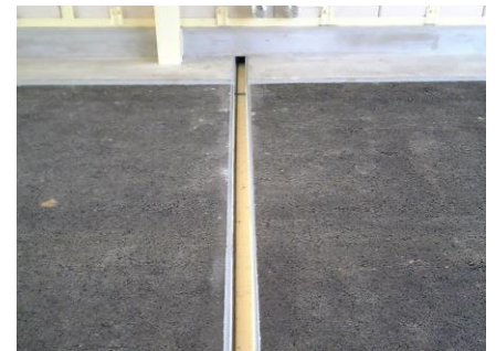
写真4 舗装の溝（トレンチ）
