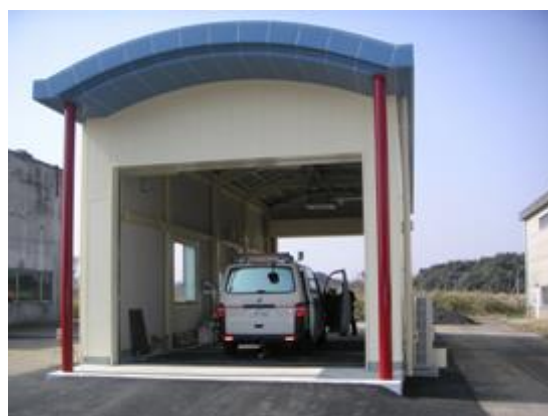
写真-1 FWD 検定施設外観
