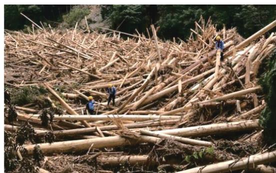
写真-2 須川第一砂防堰堤における流木の捕捉状況(妙見川)
