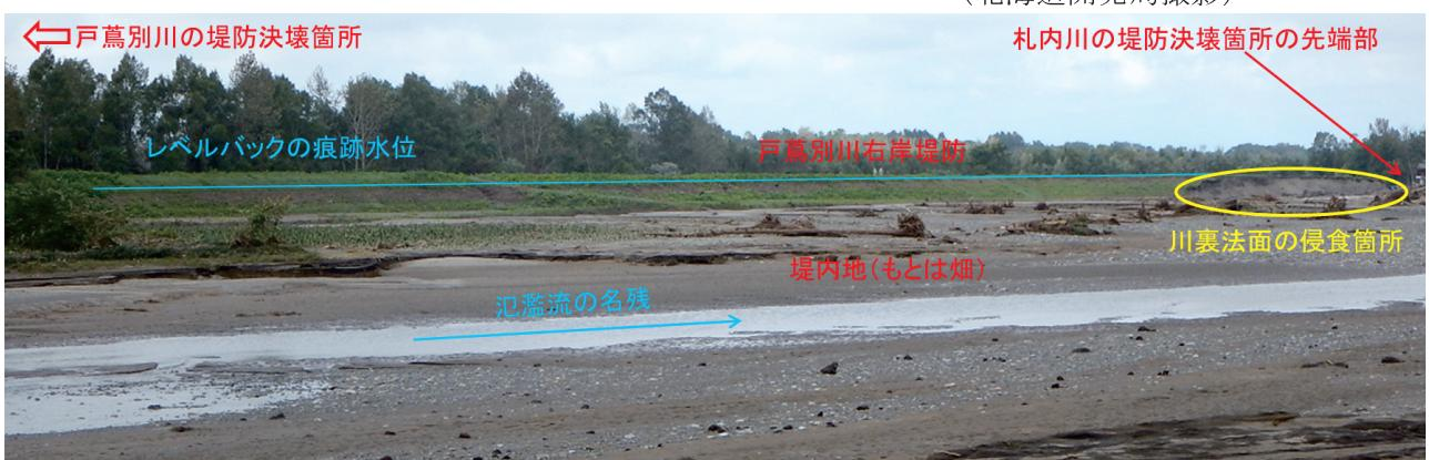
写真－5 戸蔦別川右岸堤防に残る湛水位を示すレベルバックの痕跡水位と川裏法面の侵食箇所
