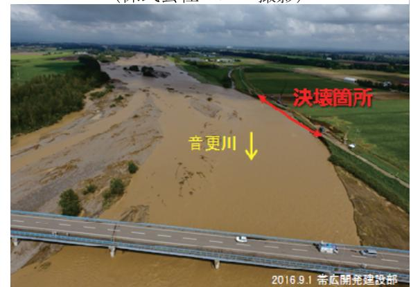
写真－3 音更川（KP21.2）の堤防決壊<sup>4)</sup>
