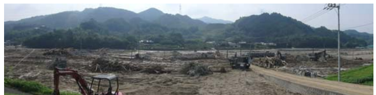
c: 赤谷川の土砂氾濫
