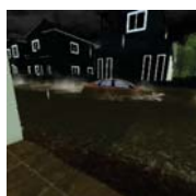
家の前の道路が冠水
