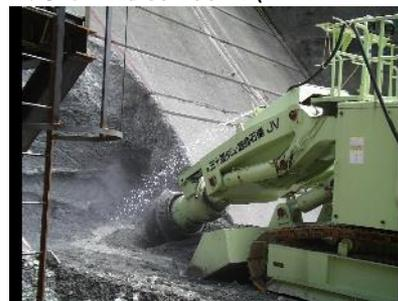
自由断面掘削機による堤体掘削(五十里ダム)
