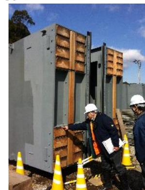
仮締切の堤体接触部の木材
