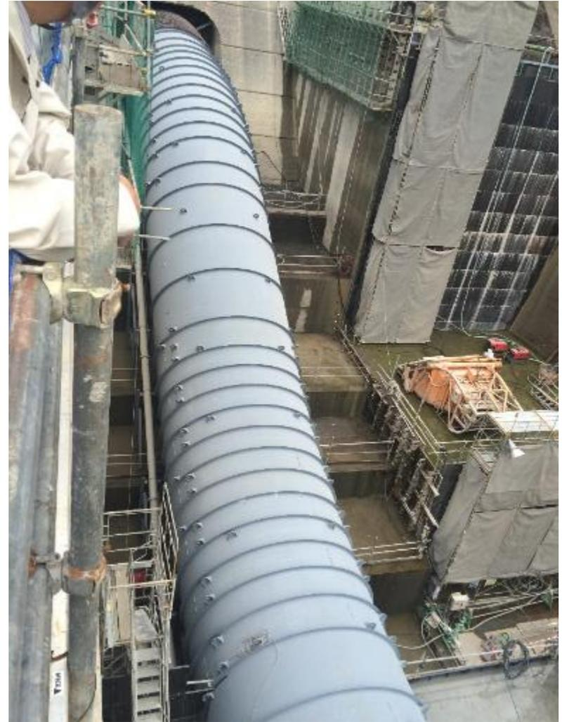
鶴田ダム増設放流管据付状況
