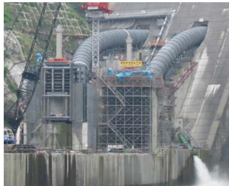
放流管曲管部(エビ継ぎ管)模型概要
