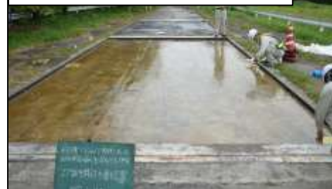
樹脂防水材料施工状況
